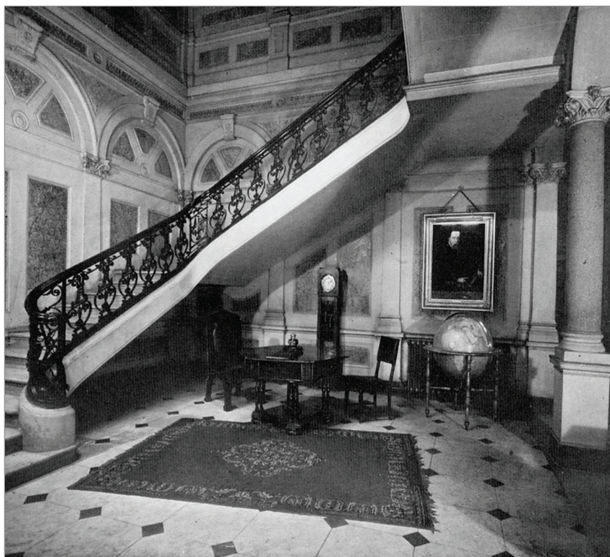
Galeria principală, străjuită pe una din laturi cu coloane de granit masiv. Scara cu balustradă de fier forjat urcă până la al patrulea etaj.
